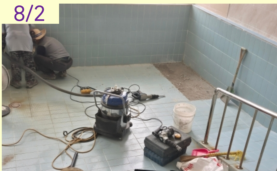
기능보강사업 '수치료실 공사'
